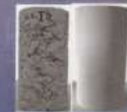
Béton non vibré - Béton vibré
